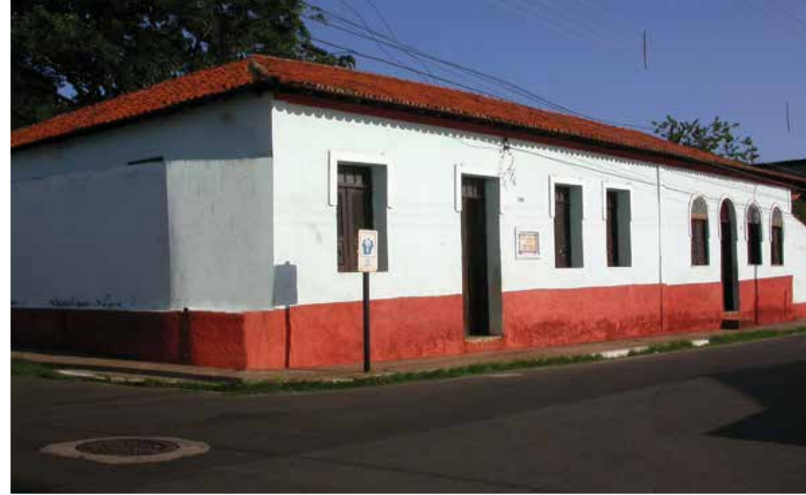
Sede da Casa das Minas. Foto Edgar Rocha
